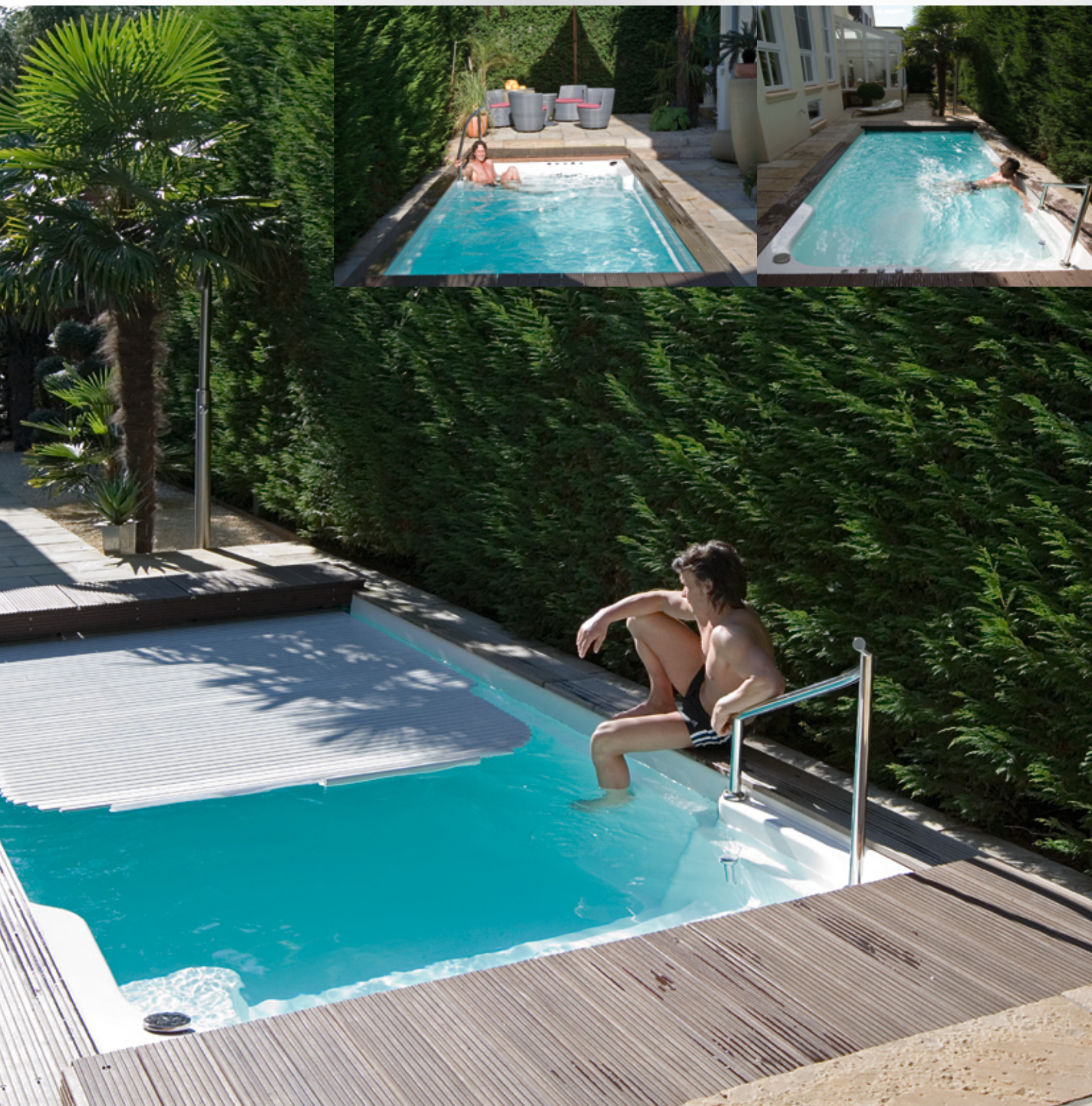
Modena 520 avec local technique et caisson pour du volet. Cette piscine a tout ce qui sert au fitness.
